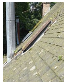
dakraam vervangen door houten plank
