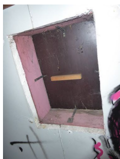
dakraam vervangen door houten plank
