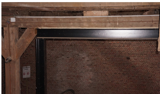
Afbeelding 47. Het stalen portiek, geplaatst bij de verbouwing van 2009-2010. Bron: Erfgoed en Visie
