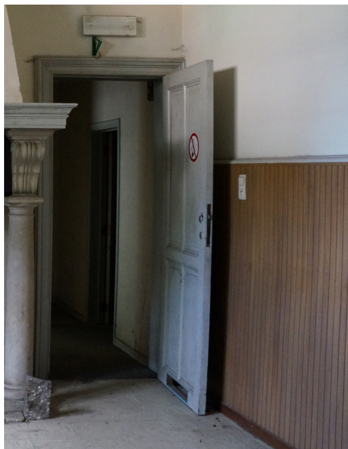
Afbeelding 59. Deur tussen W0.01a en W0.03. Bron: Erfgoed en Visie
