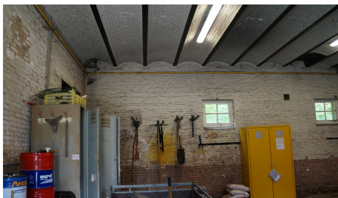
Afbeelding 48. De bakstenen troggewelfjes in S0.08. Bron: Erfgoed en Visie
