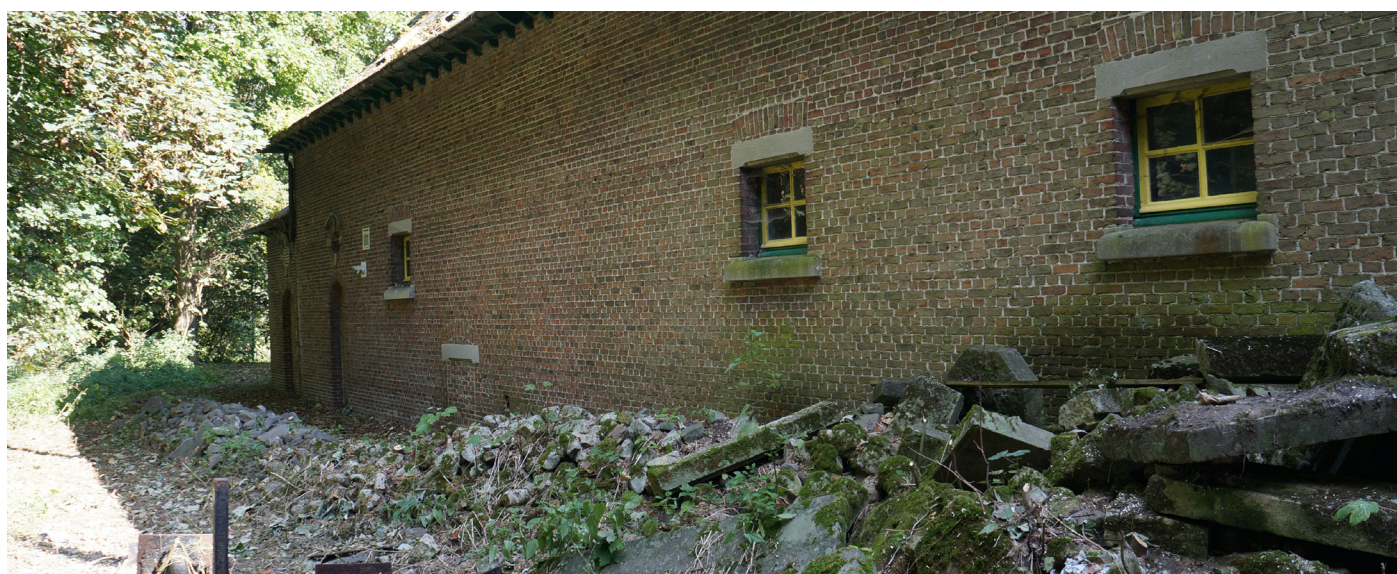
Afbeelding 18. Achtergevel van de stalling. Onderaan de gevel bevindt zich nog een gedicht mestdeurtje. Bron: Erfgoed en Visie
