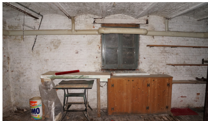
Afbeelding 34. J-1.03, bovenaan de bakstenen troggewelfjes op stalen I-liggers. Bron: Erfgoed en Visie
