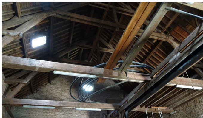
Afbeelding 44. Spantconstructie van de langsschuur. Bron: Erfgoed en Visie
