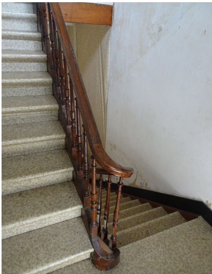
Afbeelding 33. Trap naar de eerste verdieping van het jachtpaviljoen. Bron: Erfgoed en Visie
