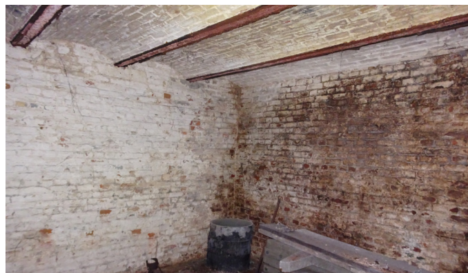
Afbeelding 40. De bakstenen troggewelfjes in K-1.04. Bron: Erfgoed en Visie
