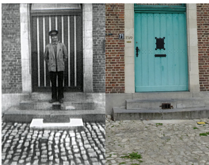
Afbeelding 25. Kasseien in banenverband en wildverband, jaren '80-heden. Bron: Stappers (2006) en Erfgoed en Visie
