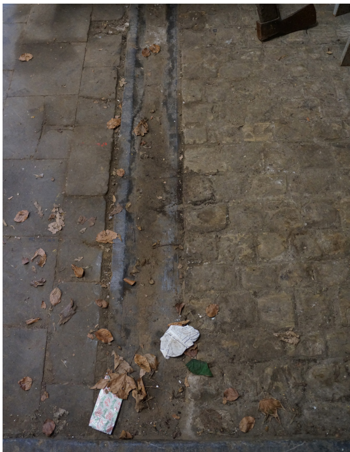
Afbeelding 49. Natuurstenen gootje in S0.08. Rechts de originele kasseivloer. Bron: Erfgoed en Visie
