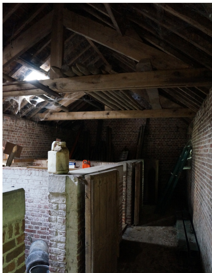
Afbeelding 53. Binnenzicht van de varkensstal. Bron: Erfgoed en Visie
